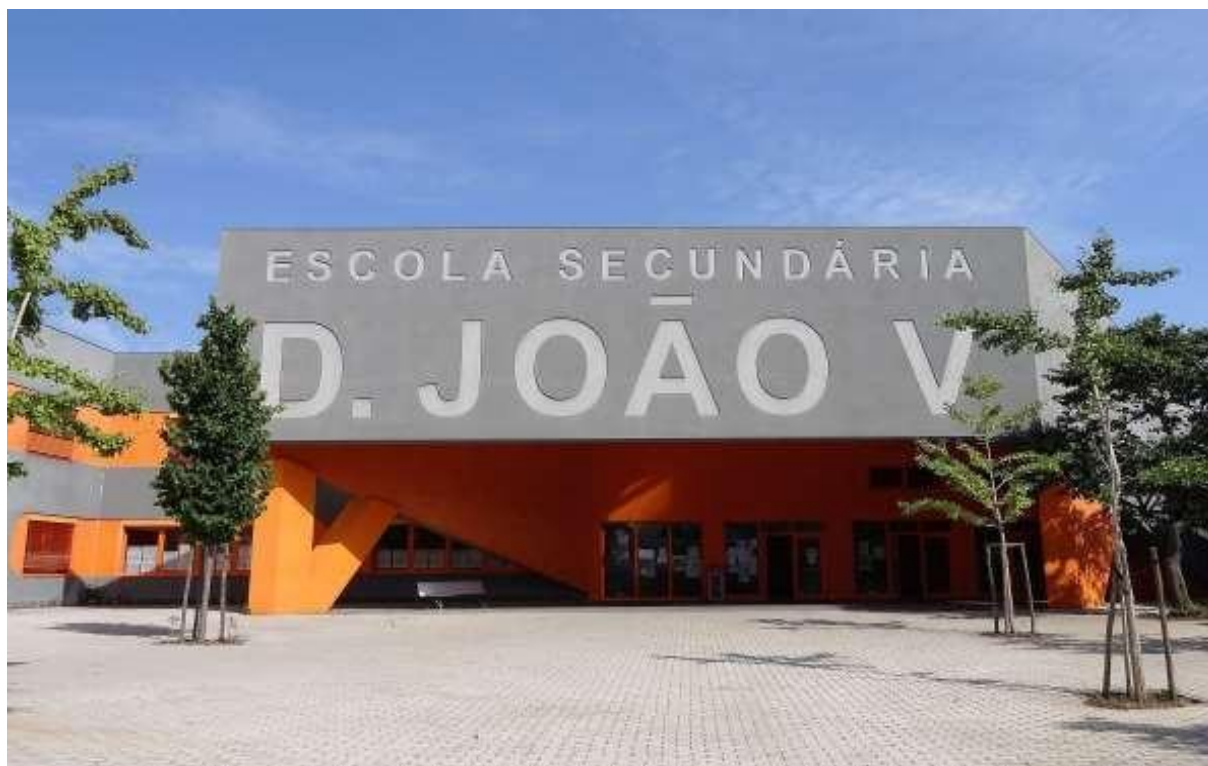
Figura 5 – Fachada do Edifício Principal
